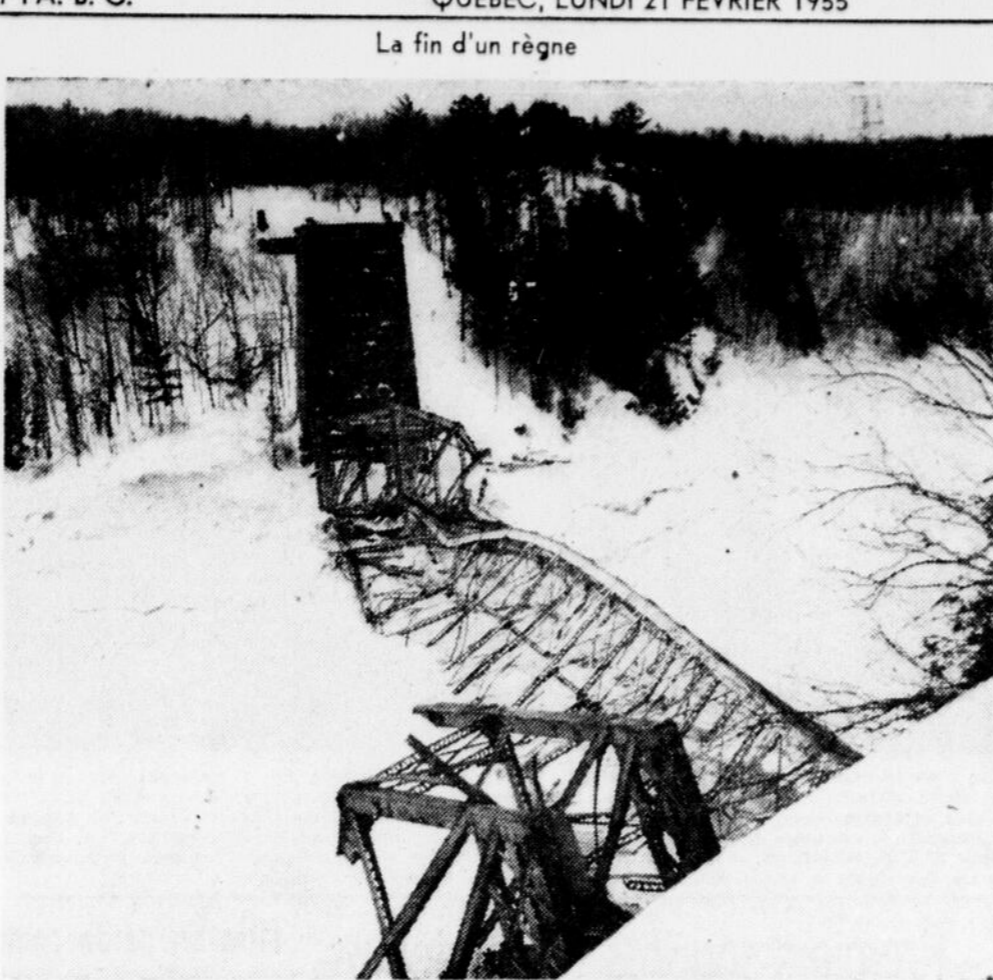
Ces ruines représentent tout ce qui reste de l'ancien pont Garneau, fermé à la circulation depuis quelques années. Il reliait, depuis 1890, les deux rives de la rivière Chaudière, à son embouchure, D'abord propriété du Conseil de comté de Lévis, il avait été cédé à M. Gérard Larochelle de St-Prospere de Dorchester, qui avait assumé la charge de le démolir.
