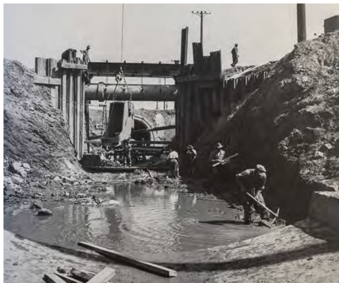
Employés au fonds de la tranchée située au coin de la rue Tanguay et de la rue Dazé.
