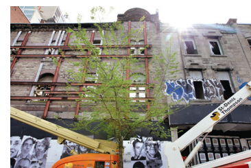
ANNIK MH DE CARUFEL LE DEVOIR Les façades du boulevard Saint-Laurent à Montréal
