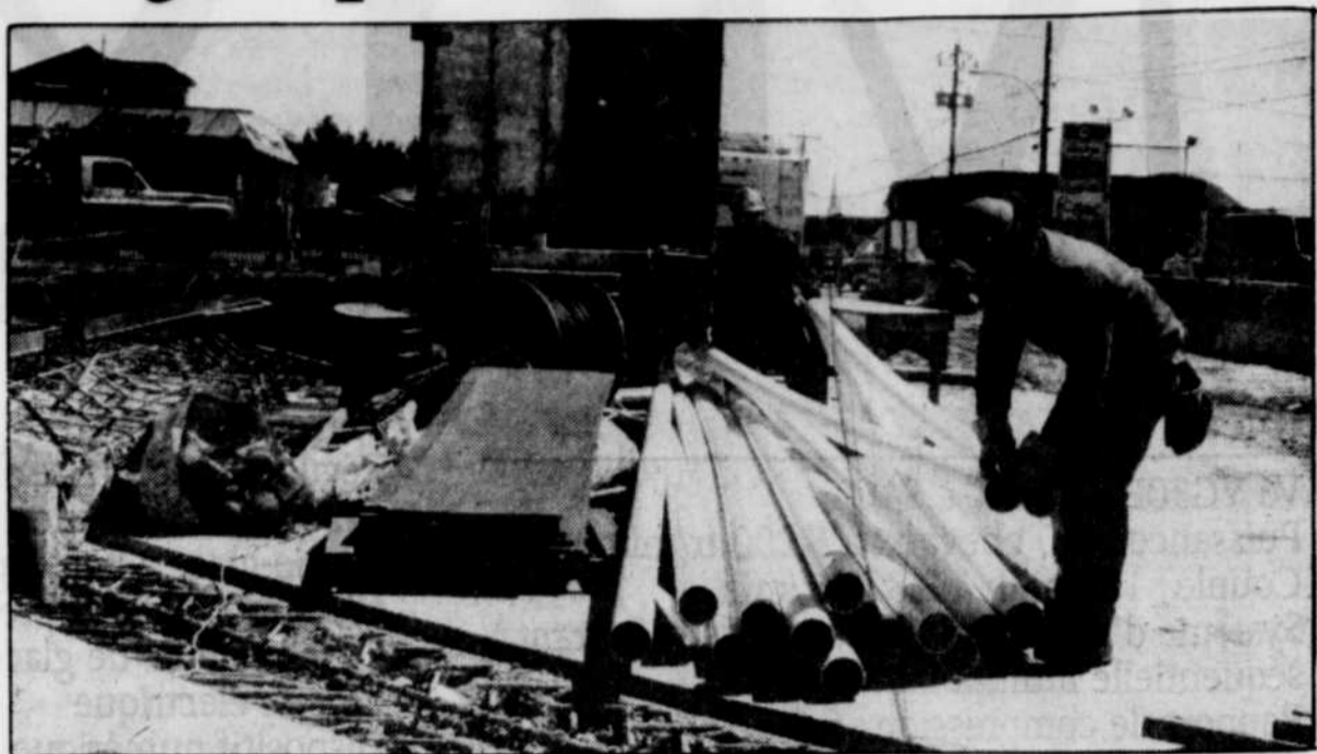
Des ouvriers sont déjà au travail sur le pont de la rivière Famine, à l'entrée de Saint-Georges.
