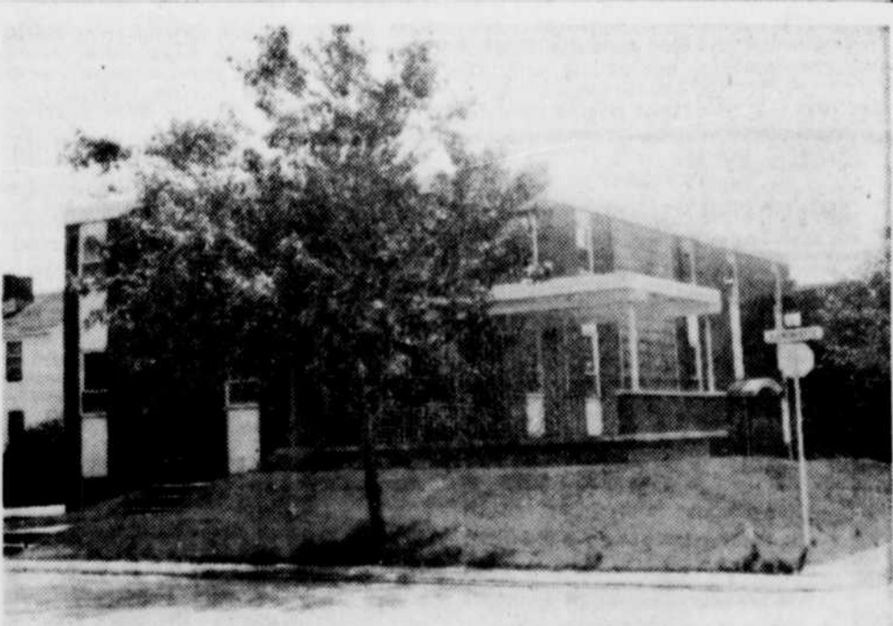
ADMINISTRATION — Le personnel administratif de la nouvelle Commission scolaire regroupée de Victoriaville entrera dans ses nouveaux locaux au début de septembre. Ils seront situés sur la rue Manfette (photo), soit à l'ancienne résidence des Frères du Sacré-Coeur, face à l'école J. P. H. Massicotte. (Photo La Tribune, Victoriaville)
