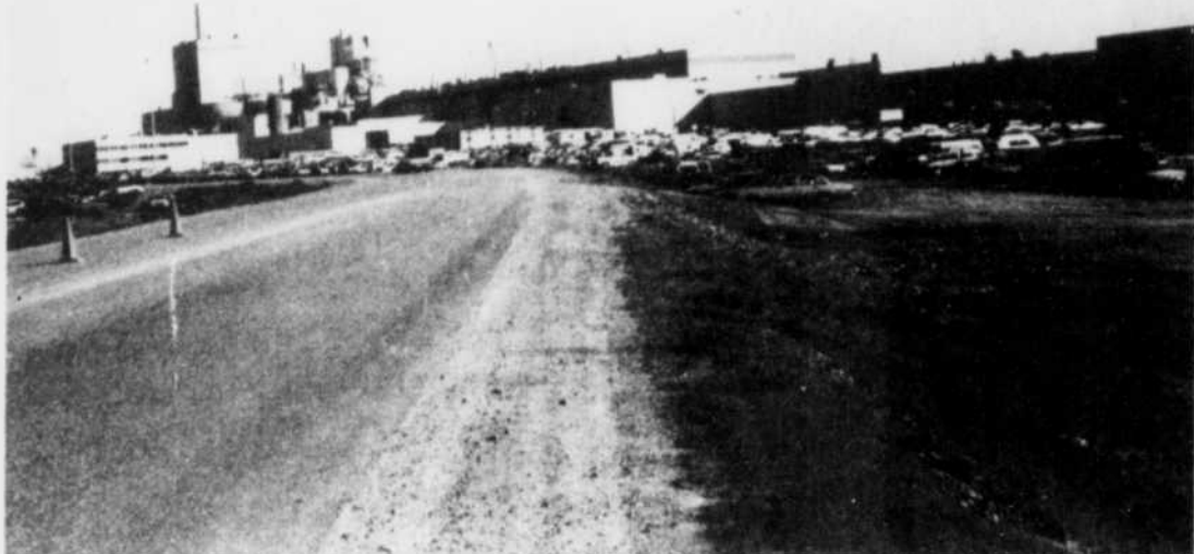
Le stationnement du chantier de l'usine Domtar, désert mercredi, était à nouveau rempli de véhicules, hier matin. Le travail
