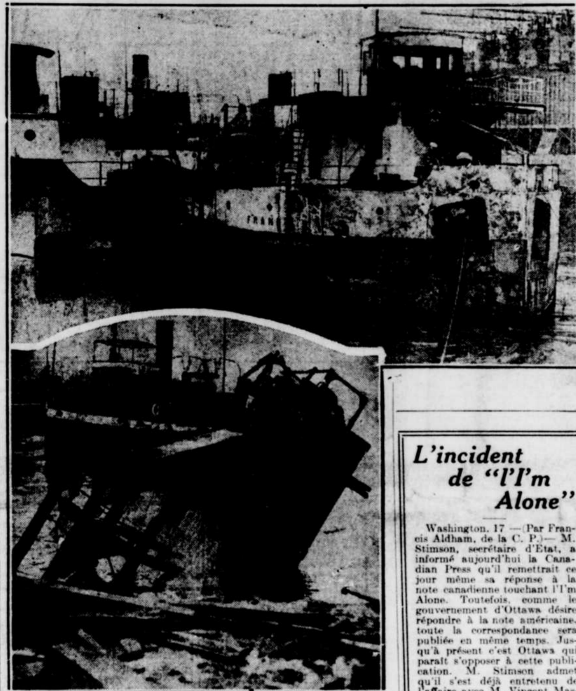
La vignette supérieure nous donne une idée des dommages causés au vaisseau "Frank P. Baird" alors que l'huile qui se trouvait sur la surface de l'eau prit feu. Plus bas les débris d'une vieille barge à demi submergée. Les pompiers ont eu beaucoup à faire pour contrôler l'incendie.
