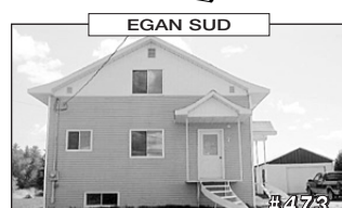
EGAN SUD Jolie maisonnette située à Egan Sud, 2 chambres à coucher, sous-sol semi fini, garage, grand terrain. Venez visiter !
