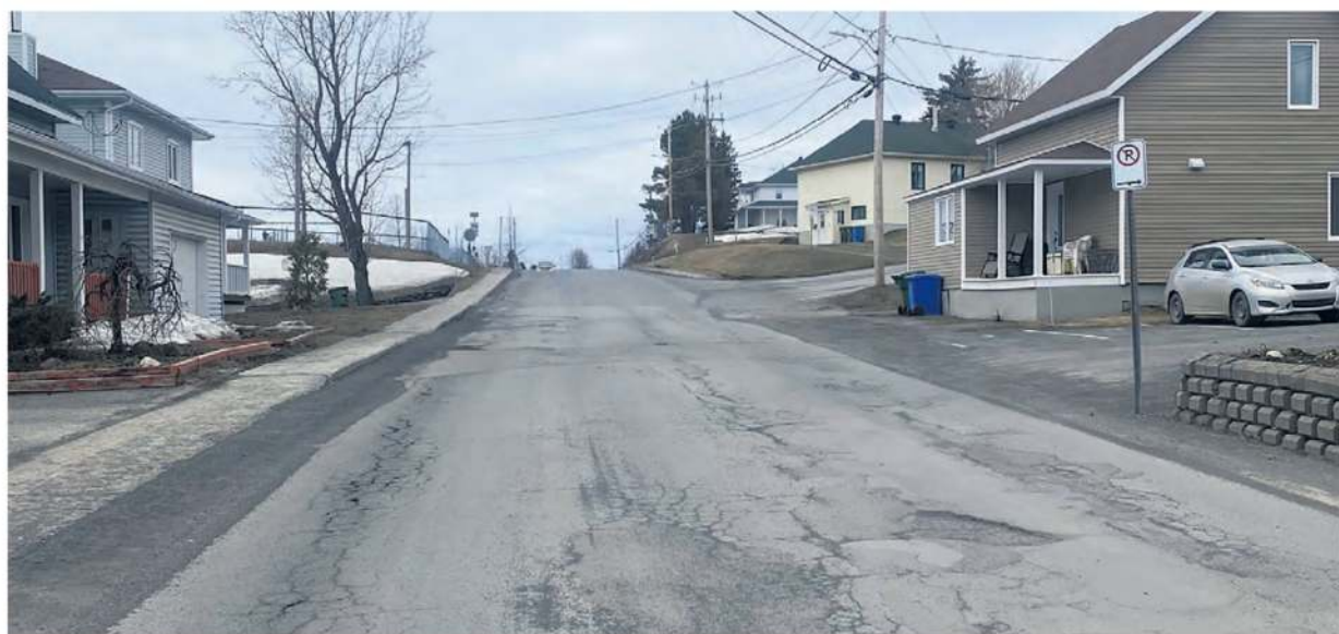
Des travaux devaient être effectués sur la rue Desbiens à Amqui durant l'été 2023.
