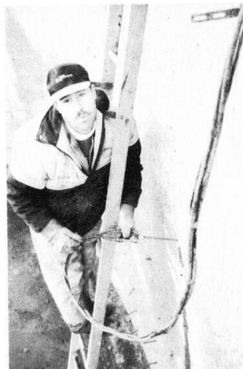
Gaetan Béliveau, surpris en plein travail, alors qu'il répare une fosse à purin. Comme quoi Epoxy va partout où il y a du béton fissuré.
