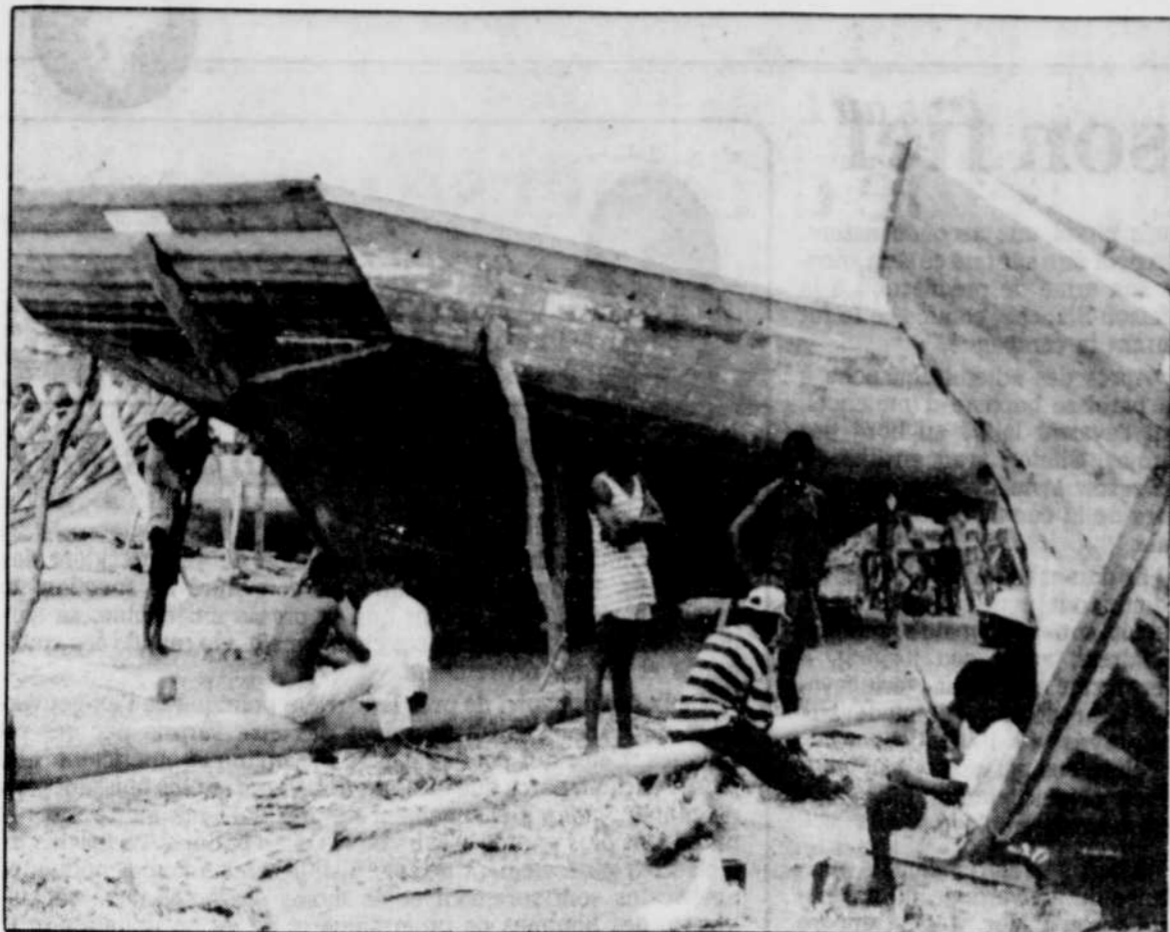
Ces Haïtiens poursuivaient, vendredi, la construction de bateaux pour le transport de réfugiés, à la plage Ça Ira. La construction de ces embarcations a provoqué une pénurie de bois de chêne, le matériau privilégié dans la construction navale, dans l'île.
