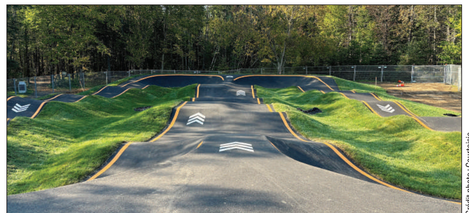
Le revêtement d'asphalte permet l'accessibilité des personnes en fauteuil roulant de sport.
