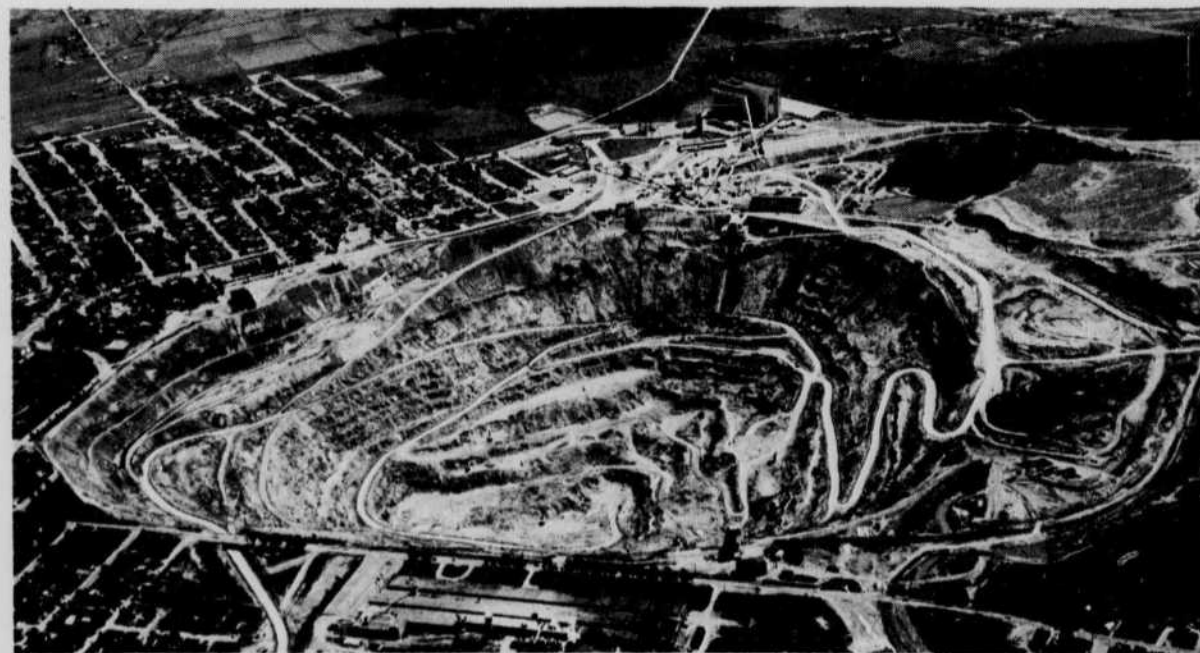
Vue aérienne de la mine Jeffrey de Canadian Johns-Manville Company, Limited, la plus grande mine d'amiante à ciel ouvert du monde libre, située à Asbestos, Qué.
