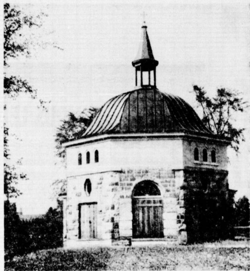
Cet oratoire de forme octogonale dédié à Notre-Dame-de-Fatima est en voie de construction à Saint-Hyacinthe, près de la maison mère des RR. SS. de la Présentation-de-Marie. En granit de plusieurs couleurs, il est surmonté d'un toit en cuivre. Ses multiples portes permettront aux pèlerins de suivre facilement, de l'extérieur, les cérémonies se déroulant à l'intérieur.
