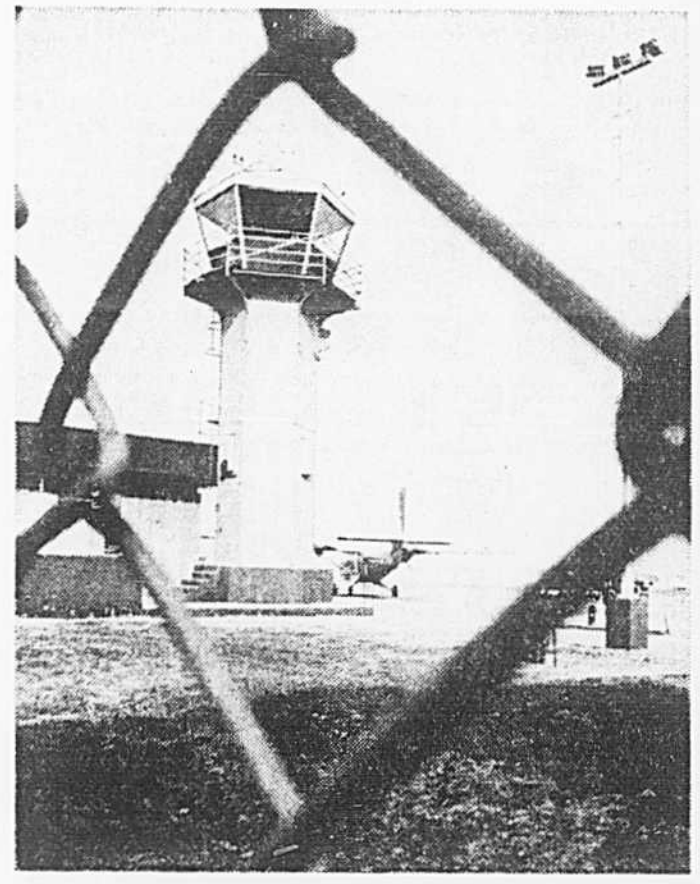
L'adaport du parc Victoria exige d'être réaménagé de fond en comble avant qu'on puisse l'utiliser de façon permanente.
