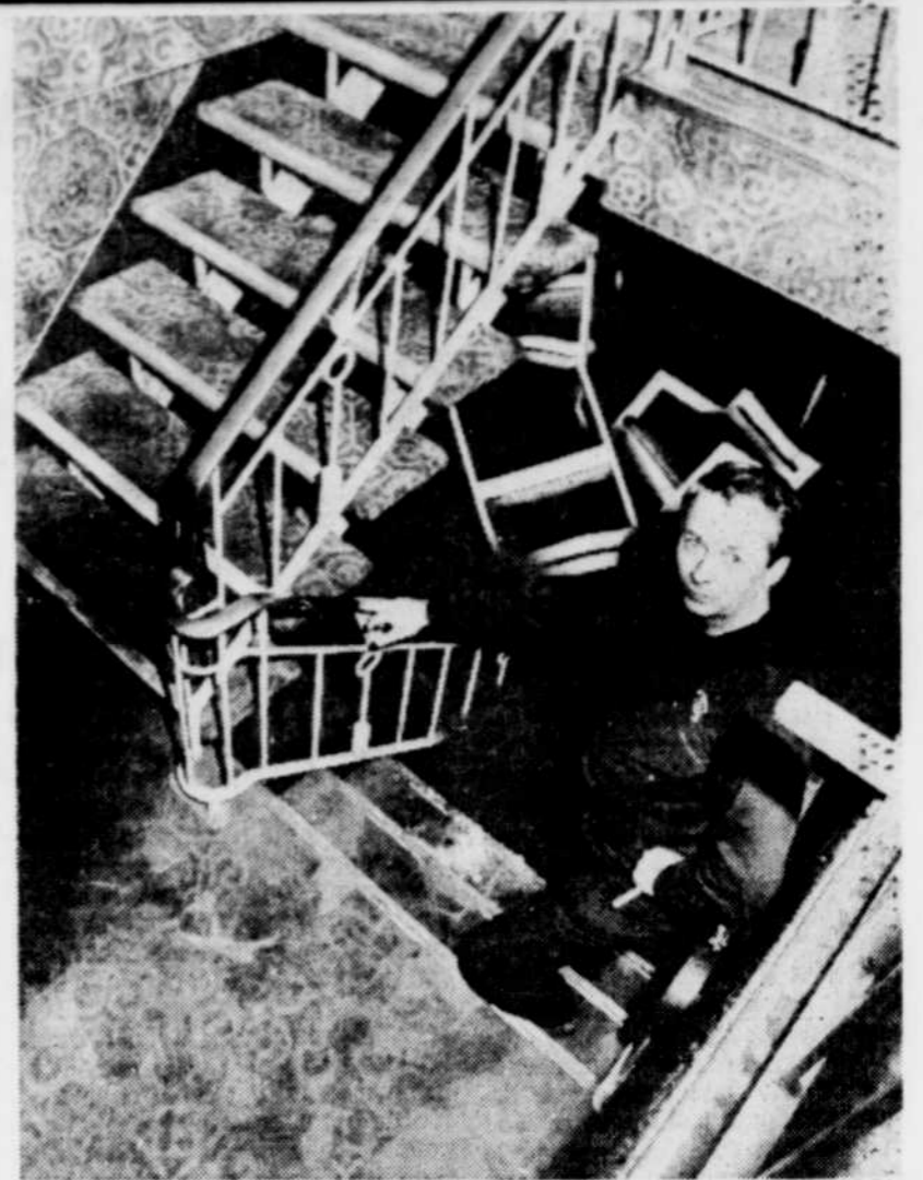
Un des propriétaires du motel Royal de Beauceville, Rodrigue Larochelle, dans l'escalier de son établissement dont le premier étage a été inondé de deux mètres d'eau.
