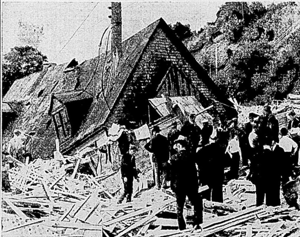
Voici la maison qu'habitaient deux familles à St-Grégoire de Montmorency avant l'ouragan qui n'en a laissé que des ruines et causé quatre pertes de vie.
