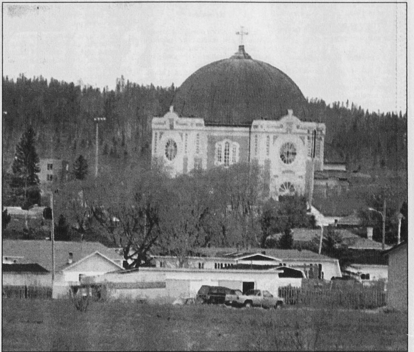
On demeure perplexe devant cette construction monumentale, érigée en surplomb pour dominer, qu'est la cathédrale Sainte-Thérèse-d'Avila, à Amos.
