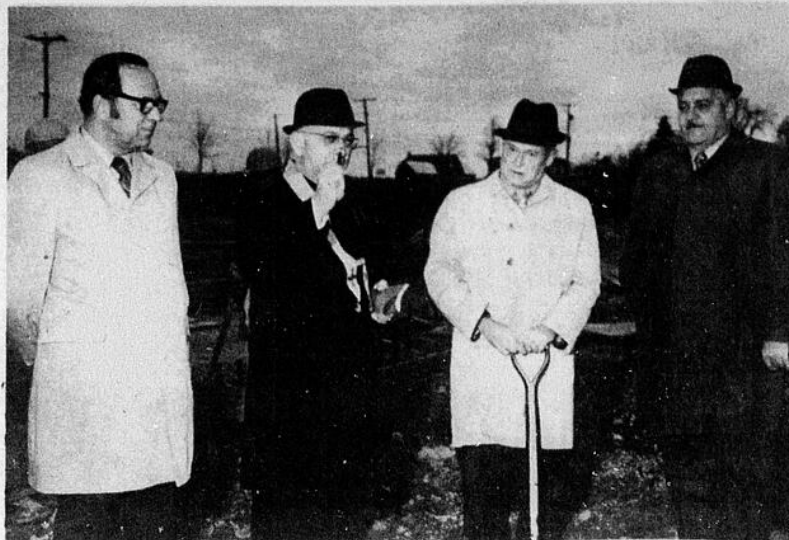
Photo prise au moment de la bénédiction par le Chanoine Eugène Dumontier, des chantiers du filtre de Berthier.
