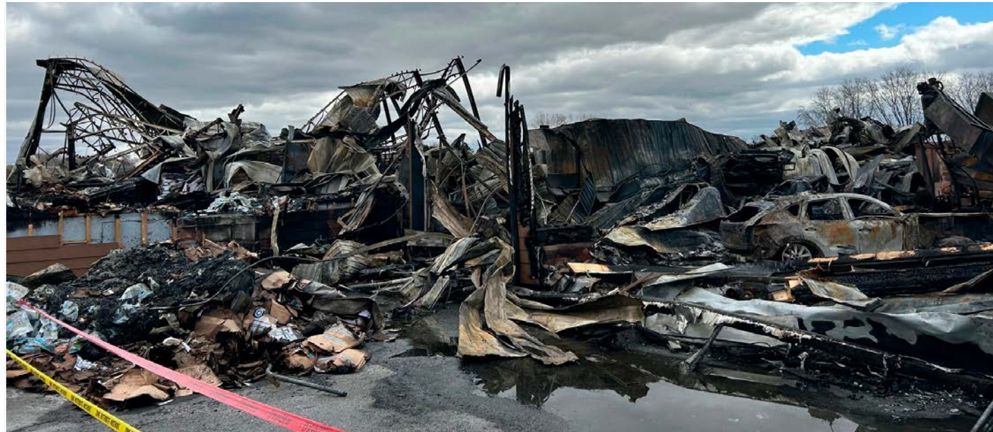
Le feu a ravagé le bâtiment qui devra être reconstruit en totalité. (Photo : Julien Dubois)
