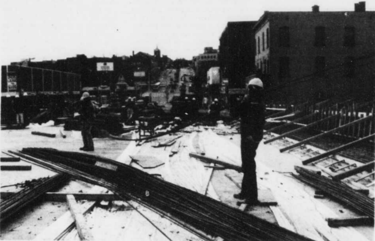
Les travailleurs ont entrepris un sprint, et seront en poste cette fin de semaine, afin que le nouveau pont Aylmer soit accessible le 10 novembre, tout de même un mois plus tard que prévu initialement.
