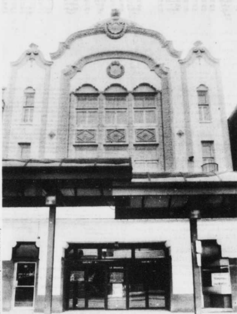
L'édifice du Granada, rue Wellington Nord.
