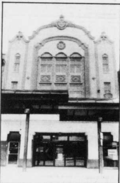
La façade rénovée du Granada.
