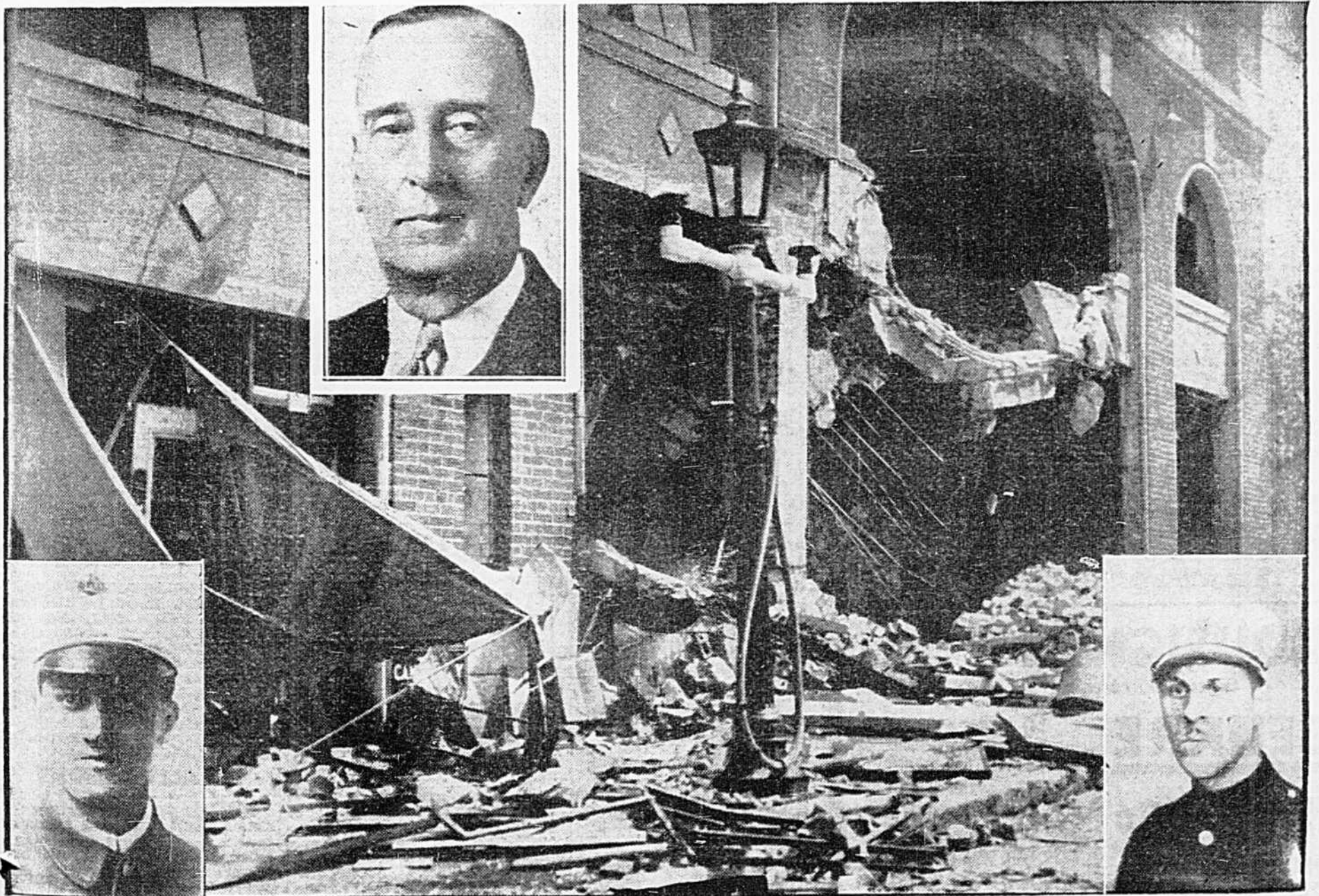
Cette photo donne une idée de la violence de l'explosion qui s'est produite hier après-midi au garage Laurier, rue Laurier, entre la rue Hutchison et l'avenue du Parc, au cours d'un incendie. Trois pompiers ont été tués et une centaine de personnes ont été blessées et conduites dans les différents hôpitaux de la ville. A gauche, l'un des morts, le pompier Lepage; à droite, une autre des victimes, le pompier Senécal. Au centre, le directeur Carson, grièvement blessé et dont l'état est critique.—Voir comptes rendus en pages 2, 3 et 5 et autres clichés en dernière page. (Photos l'«Illustration Nouvelle».)
