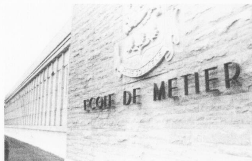
Le Pavillon André Morissette de Plessisville.
