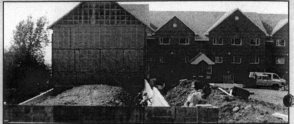
La deuxième phase des travaux débutera au mois d'août 1996.
