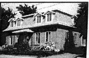
RIVIÈRE-DU-LOUP: Rue Fraser: Résidence avec garage triple. Plusieurs rénovations récentes. Zonage commercial. (5677)
