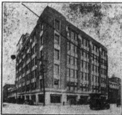
Le nouvel édifice Dupuis Frères, érigé par Archambault & Leclair. Ingénieur: Arth. Surveyer; Architecte: H. S. Labelle.
