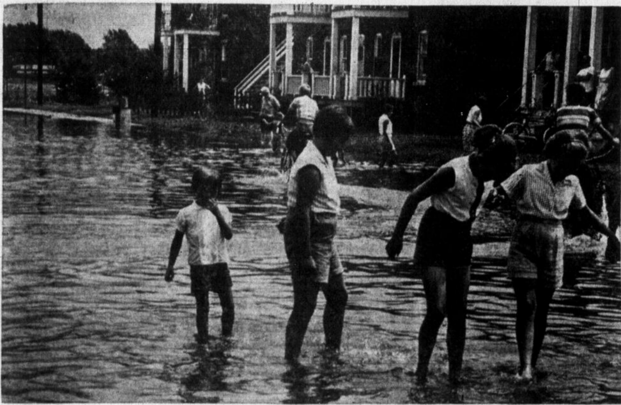
VENISE A SAINT-JEAN: Quelques heures après l'orage de mardi, le photographe a pris la photo ci-dessus. On peut voir l'état de la rue Mayrand pris à l'angle de la rue Mercier, qui était recouverte d'une bonne couche d'eau qui dépassait les huit pouces. Sur le Boulevard du Séminaire, la couche d'eau a atteint à certains endroits, une épaisseur de 25 pouces. (Photo Ken Wallett)
