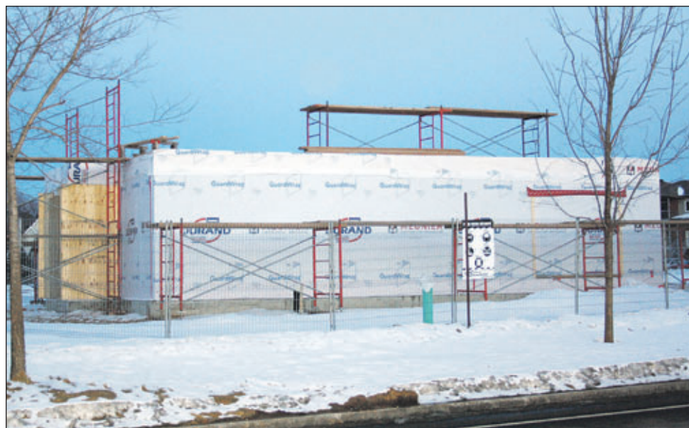
Les travaux de construction de la Maison des jeunes viennent de reprendre.
