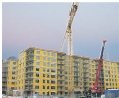
La phase II des Boisés du Séminaire est présentement en cours.
