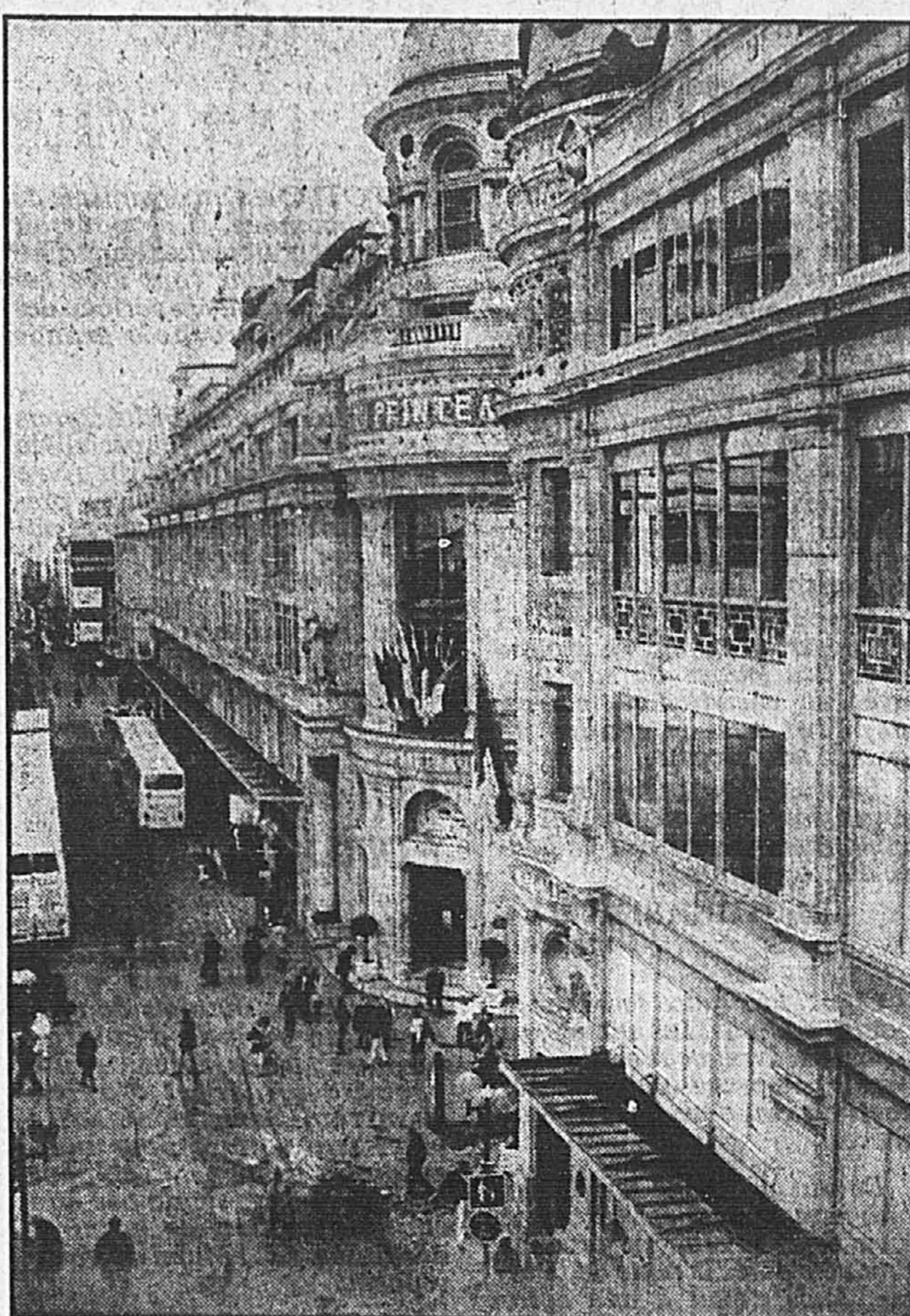
À l'arrière du boulevard Haussmann, rue de Provence, on découvre une façade ancienne des magasins Printemps. Cette vue en plongée est prise de la terrasse du neuvième étage.
