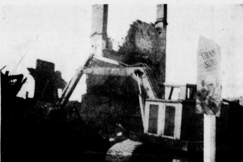
DEMOLITION — Contrairement à d'autres ruines d'incendies qui sont encore debout après plusieurs mois, on a déjà procédé dans le cas des édifices situés à l'intersection des rues Bérard et Hériot à la démolition. On sait que le drame ne s'est produit que jeudi matin et déjà hier, comme le démontre la photo, on avait commencé le travail de nettoyage des ruines encore fumantes. (Photo La Tribune, Drummondville)
