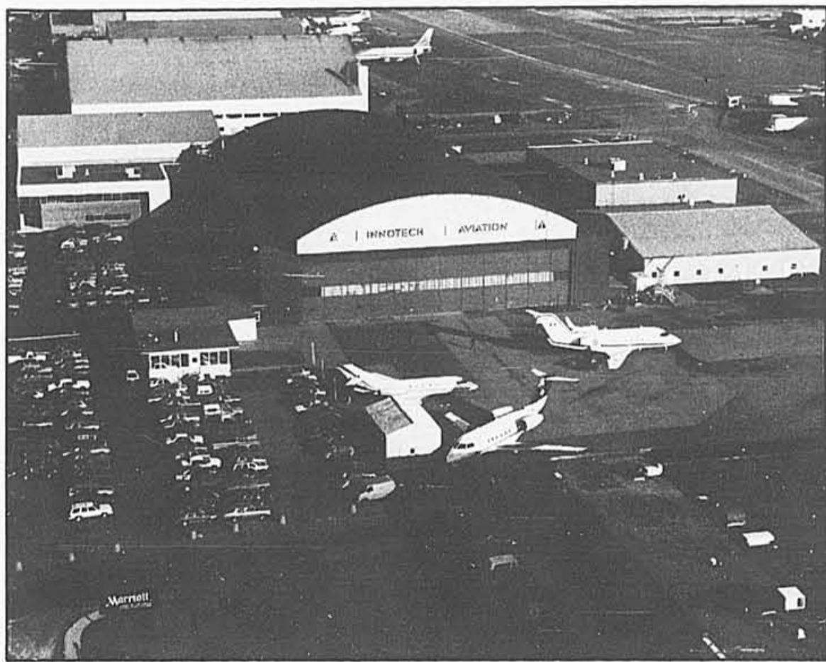
Les installations ultra-modernes d'Innotech Aviation Ltée à Dorval.
