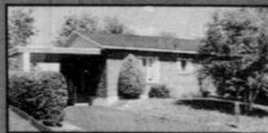
Secteur Haute-Ville: constr. 93, 100% brique, 2 c.c., bois franc, armoires en érable, terrain très privé.
