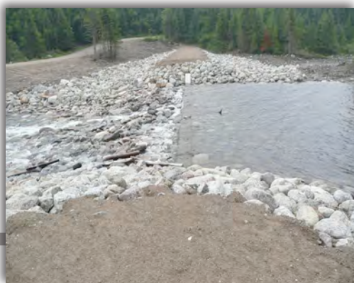
▼ Déversoir en enrochement
