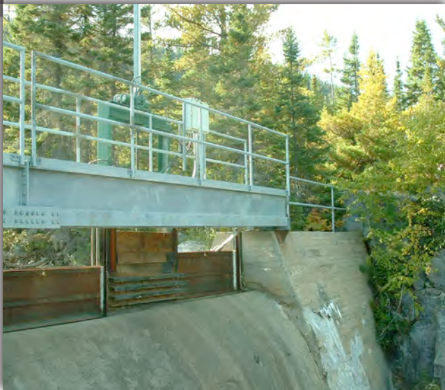
Vannes à glissière munies d'un mécanisme de levage
