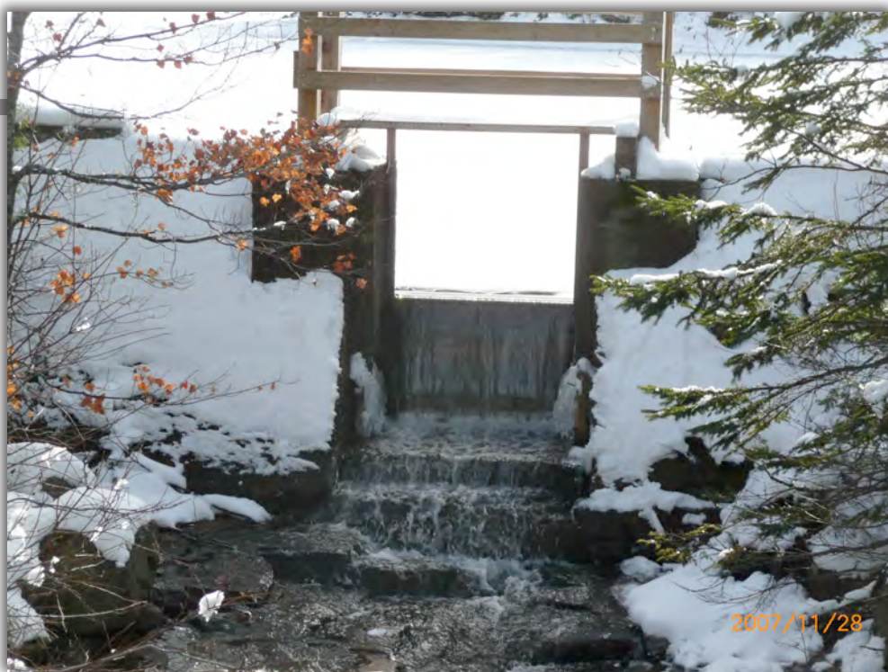
Déversoir sans mécanisme de levage ▼
