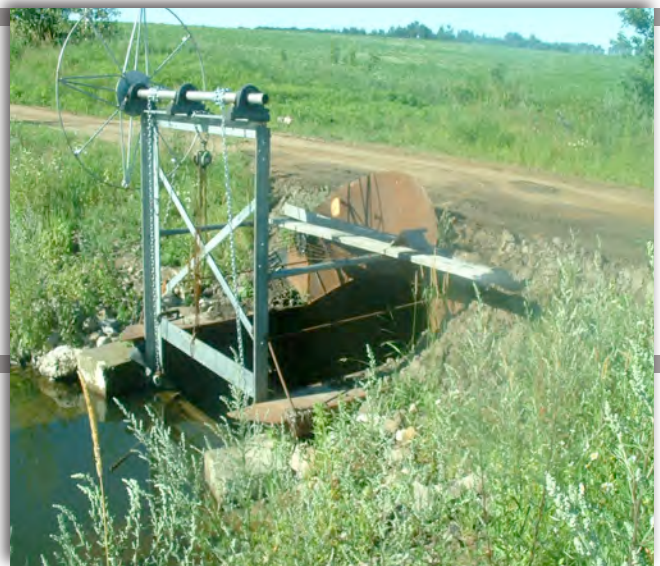
Vannes à glissière munies d'un mécanisme de levage
