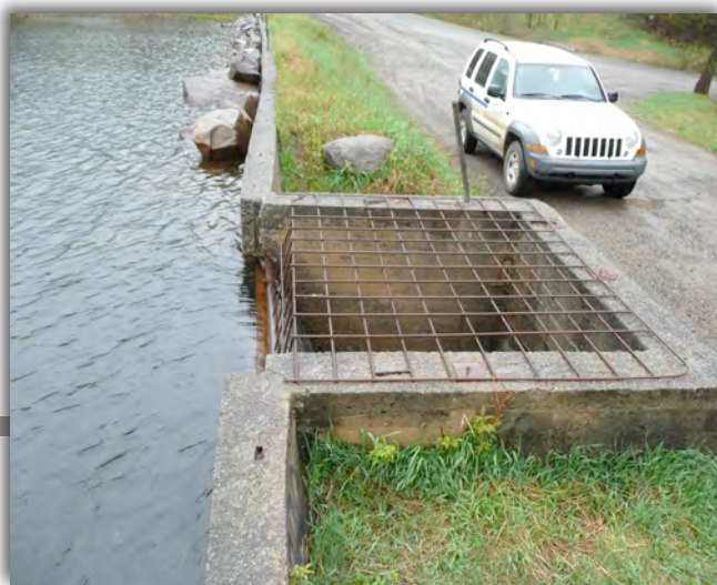
▲ Déversoir muni d'un grillage protecteur
