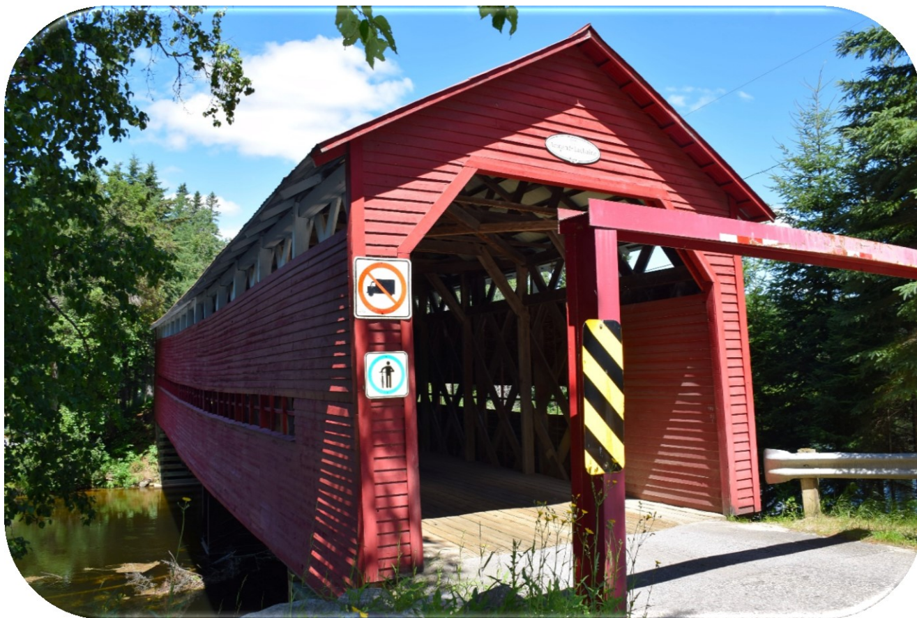
Pont Armand-Lachaine, Chute-Saint-Philippe
