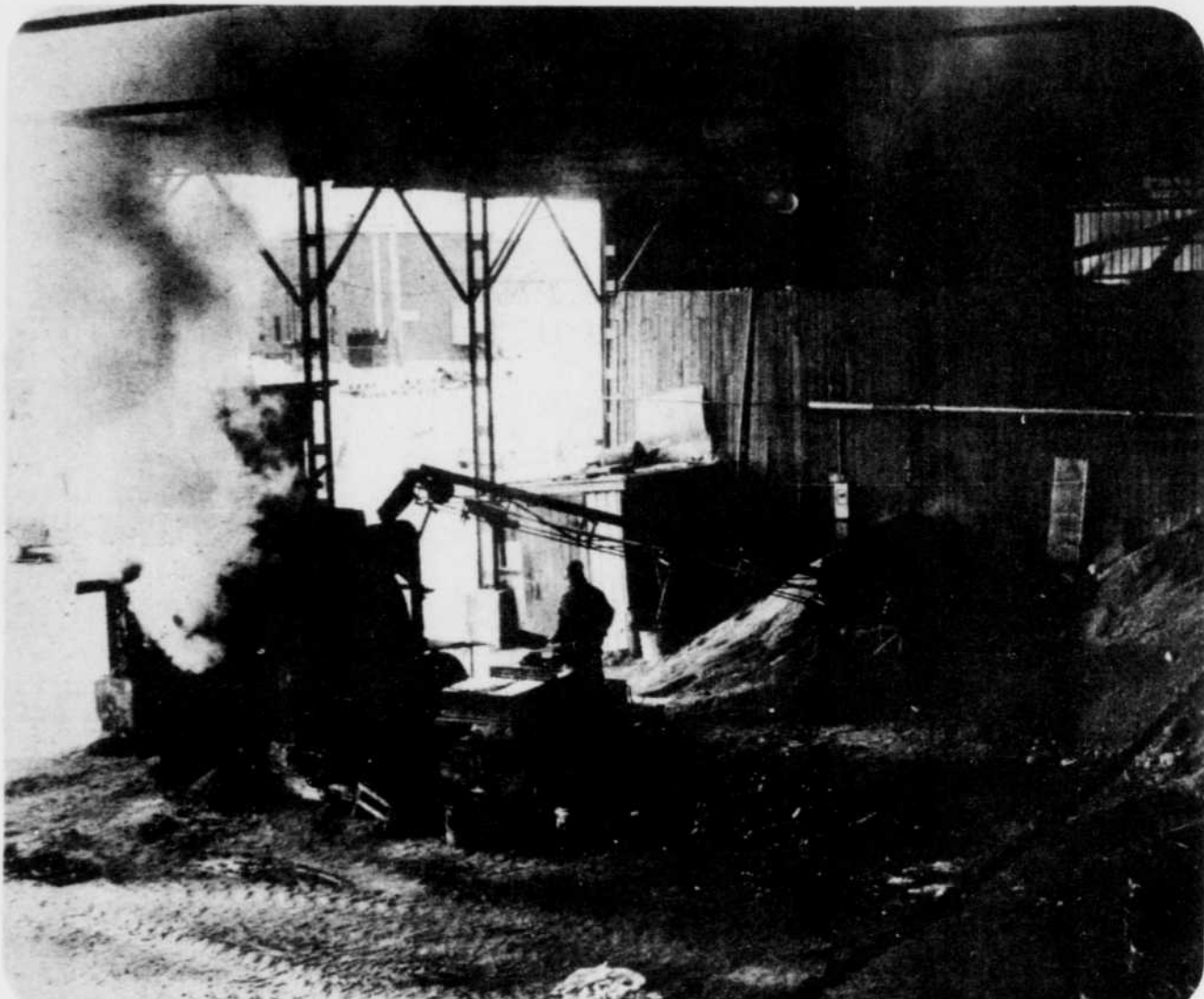
Loin de dater de 15 ou 20 ans, cette photo de l'usine d'asphalte de la ville de Sherbrooke a été prise hier. L'endroit sert également d'entrepôt
