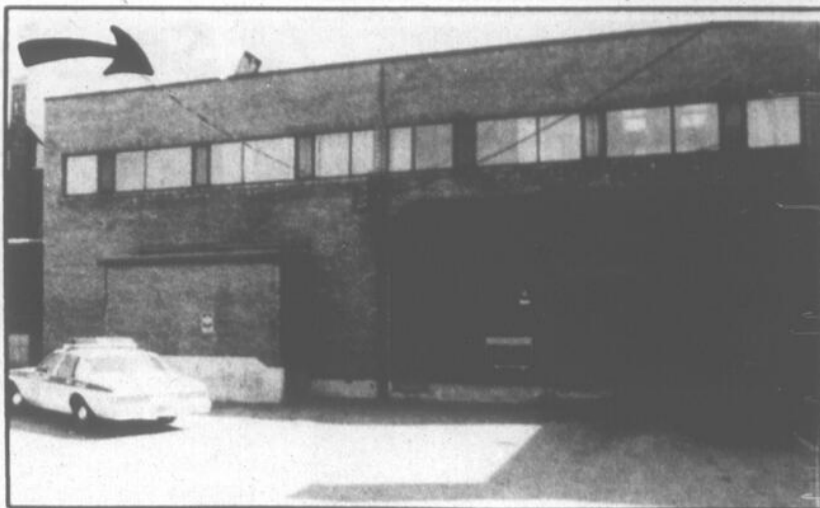
C'est près de l'endroit indiqué par la flèche que se trouve le système de ventilation qui a fait défaut. L'édifice fédéral abrite Postes Canada, Emploi et Immigration Canada et Douanes Canada. (photo Michel Leclerc)
