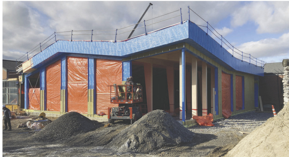
Les travaux de réfection du complexe aquatique ont débuté le 21 février 2022 et l'entrepreneur général devrait livrer le bâtiment complété vers juin. Photo gracieuseté
