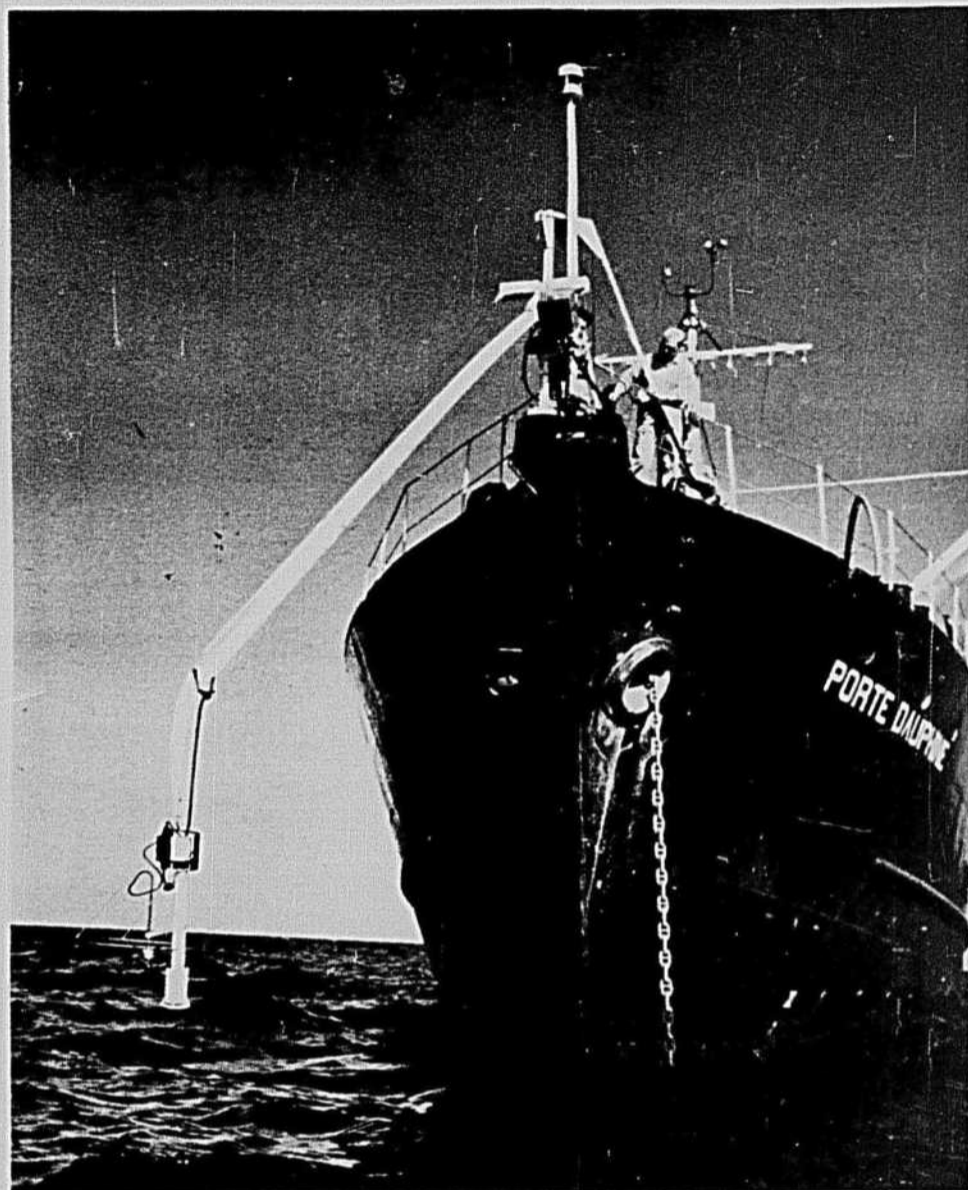
C'est à l'aide d'un treuil bien particulier, auquel on a fixé des instruments, que l'on obtient des données sur les conditions atmosphériques variant du niveau de l'eau.
