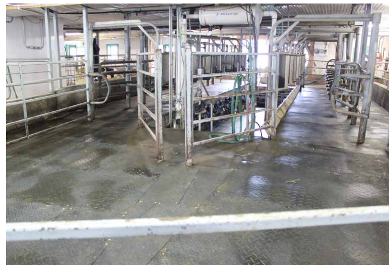
Salle de traite usagée installée dans l'ancienne étable à stabulation entravée
