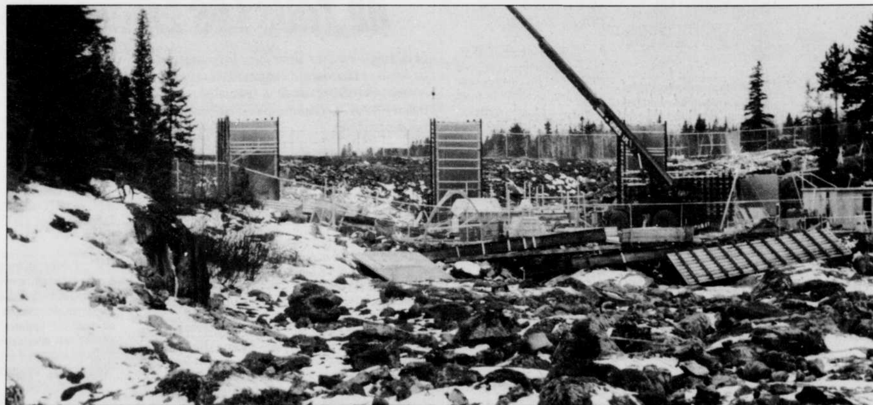
La reconstruction du barrage no 5 est amorcée depuis le début de Noël et devra être complétée en mars prochain, à temps pour la crue printanière.
