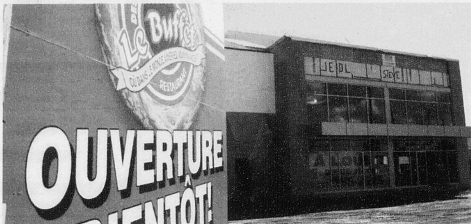
Le Buffet des continents ouvrira ses portes à la fin du mois de juin.
