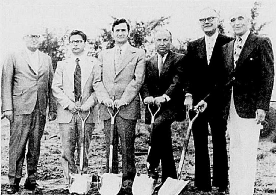
Le nouveau Centre de Services techniques des tracteurs Bellarus actuellement en construction à Boucherville est en même temps la première industrie russe à s'implanter au Québec. À la cérémonie officielle qui a marqué le début des travaux, on remarque dans l'ordre habituel: MM. Marcel Hubert, directeur général du Centre, Vladimir A. Tsukanov, vice-président de Bellarus Équipement, Yvon Julien, maire de Boucherville, Vassili N. Myshkov, chef de la délégation commerciale soviétique au Canada, Walter L. Fitzpatrick, gérant général de Belarus Sales et Clovis Langlois, commissaire industriel de Boucherville. Photo TCN
