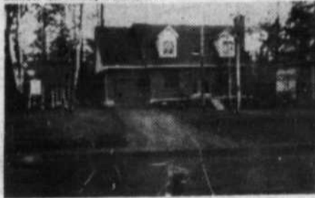
7 — SAINT-HILAIRE — Superbe canadienne à lucarnes, terrain boisé, piscine creusée, construction de qualité, secteur recherché. Appelez Lise D. Dufresne 467-2156, 467-6578.
