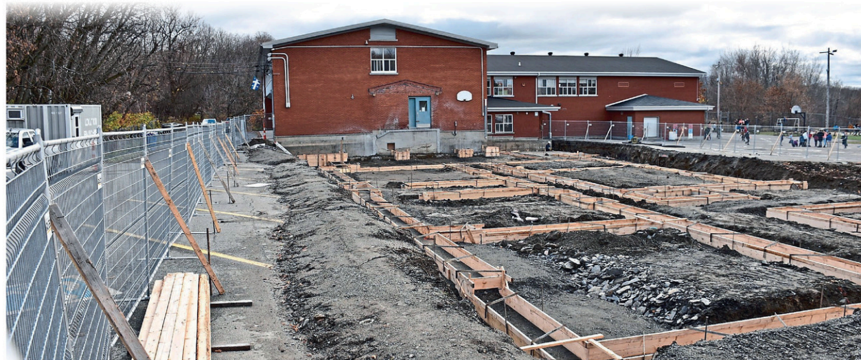
L'école primaire Louis-St-Laurent de Compton aura bientôt un nouveau visage. Les travaux d'agrandissement ont débuté sur le site. (Photo Le Progrès de Coaticook - Vincent Cliche)
