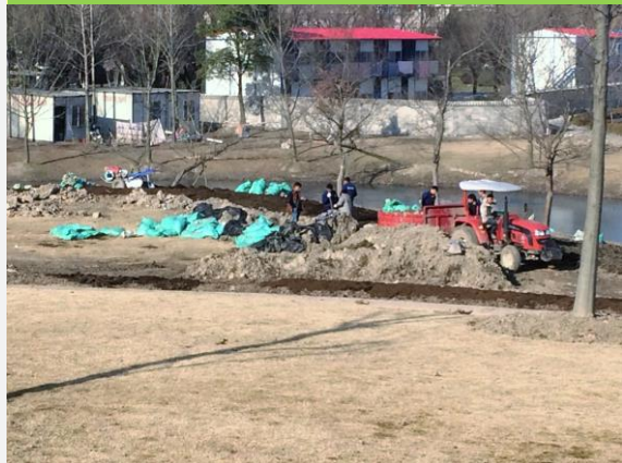
Projet de remédiation des sols par section de 5 à 10 hectares
