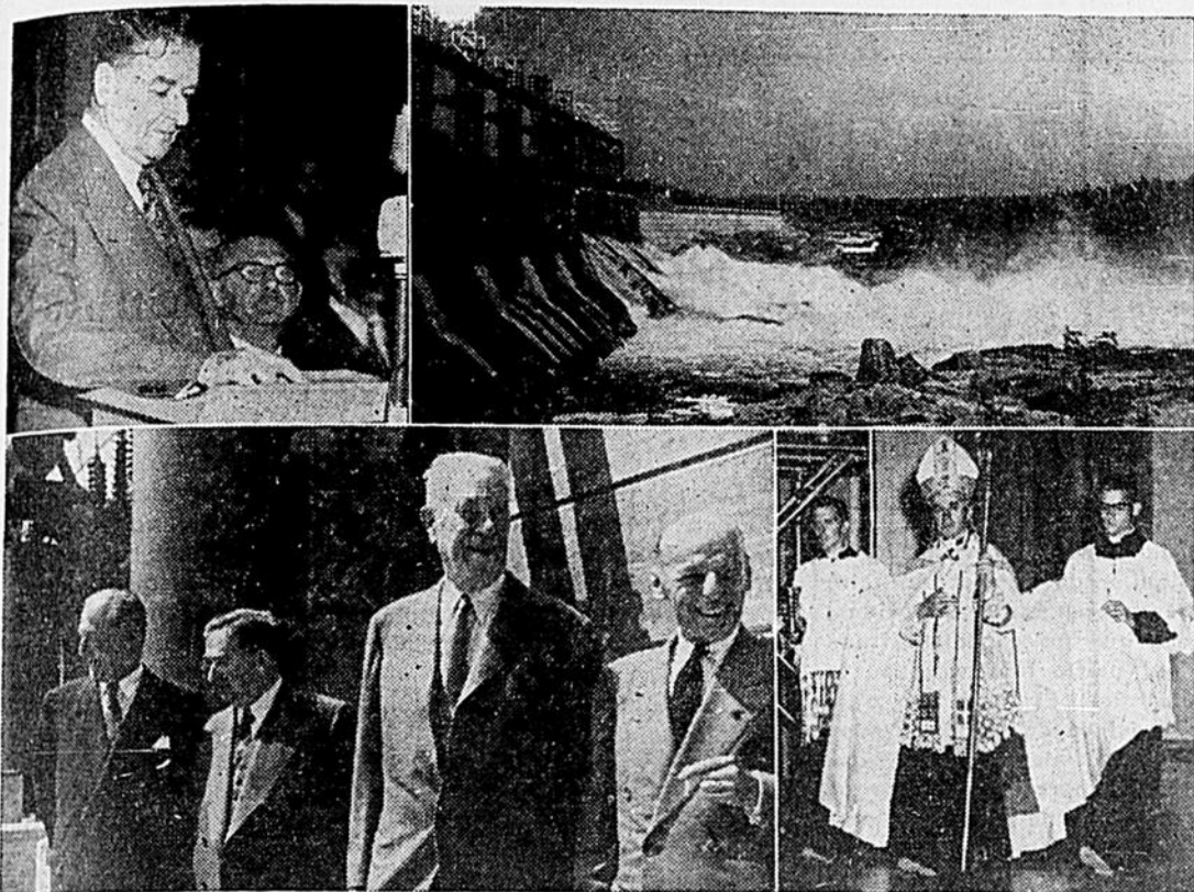
L'honorable Maurice L. Duplessis, premier ministre de la province de Québec (en haut, à gauche) presse un bouton en guise de symbole lors de l'inauguration officielle du barrage McCormick près de l'embouchure de la rivière Manicouagan. L'excédent d'eau de la centrale produisant 90,000 h.p. (en haut, à droite) s'écoule par son canal de fuite.
