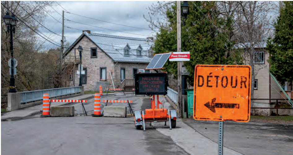
Des ponts bloqués parce que la rivière était sortie de son lit
