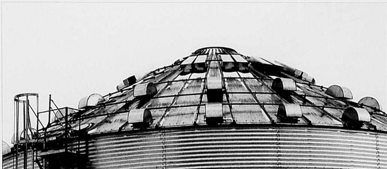
La ventilation du silo a été remodifiée, les sorties sont placées plus haut.
