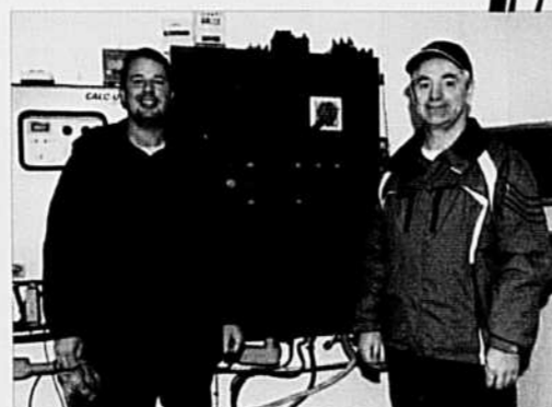
Sylvain Cardinal et Michel Choquette posent fièrement devant les panneaux de contrôle. Pour eux, l'automatisation du système était essentielle. Ils ont fait appel à un technicien pour la programmation de l'automate.
