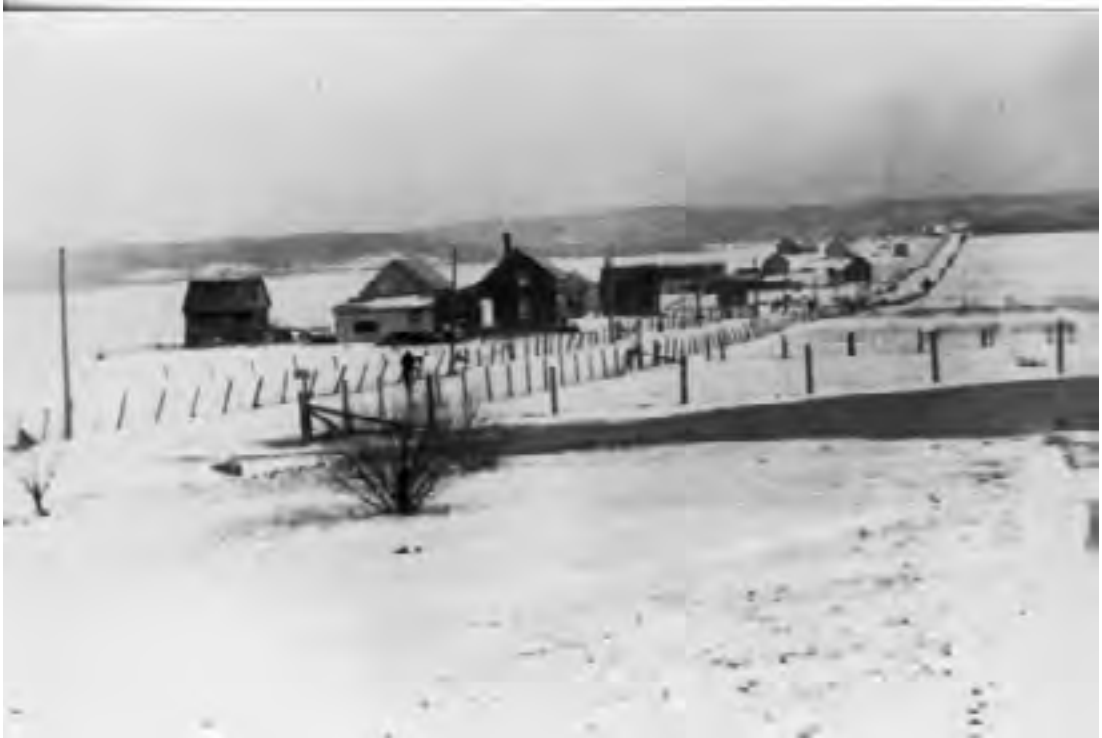
// PH9-4-9, Architecture et bâtiments, Résidences privées dans le rang 8 et 9 de Fugèreville chemin de Latulipe en 1940.
