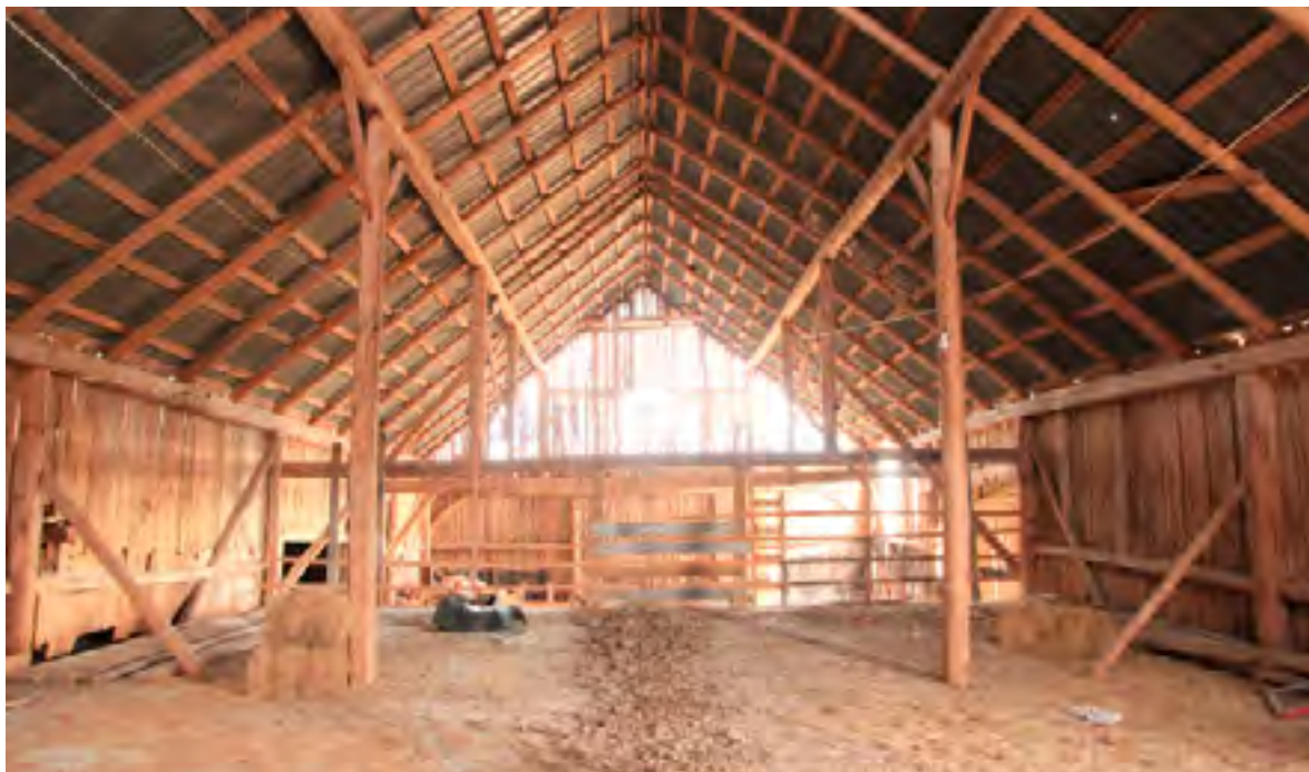
// Deuxième plancher de la grange Sud (1966)
