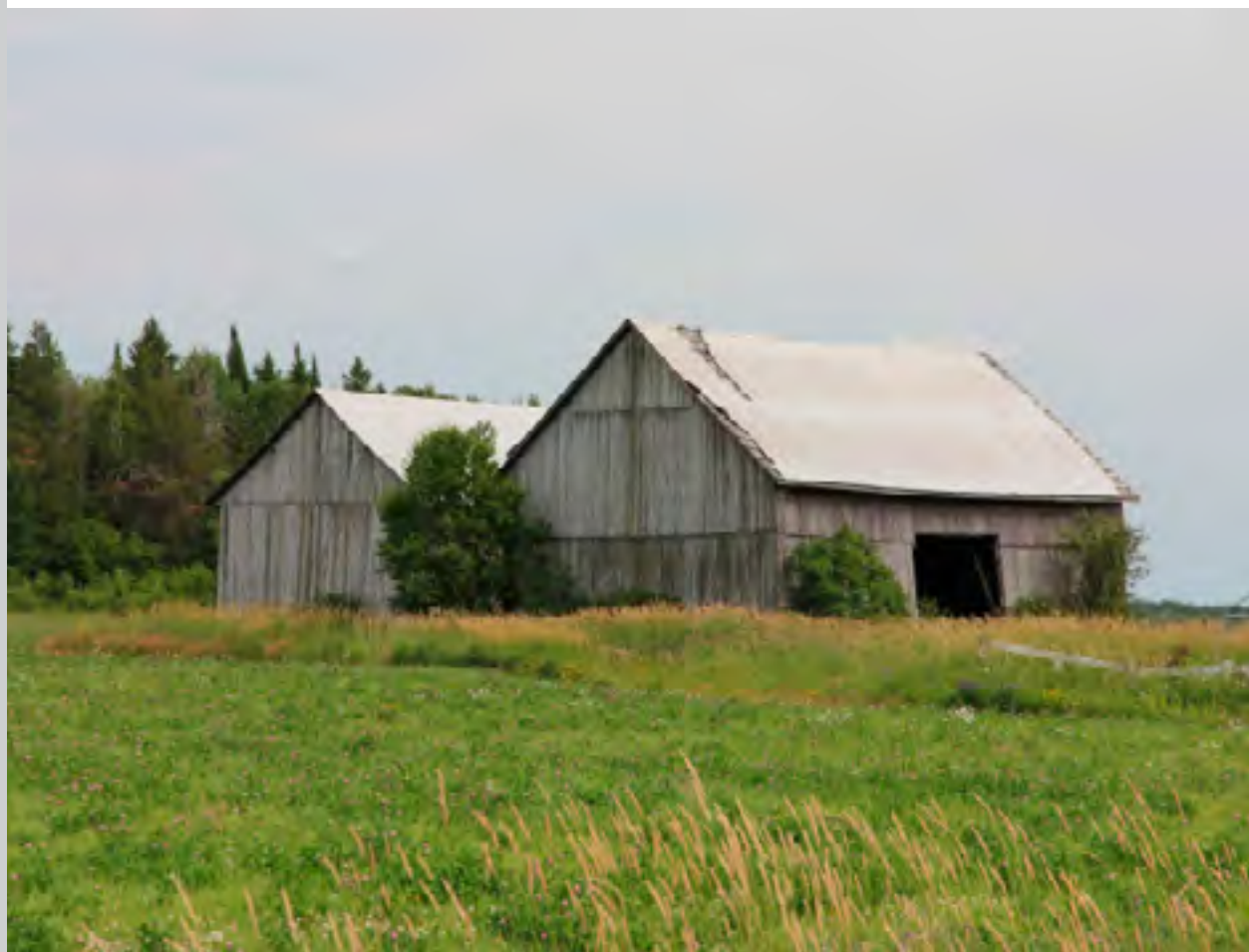
14 Adresse // 768 Chemin des 3 e et 4 e rang sud, Guérin, QC Propriétaire // Viateur Perron Granges à combles triangulaires
