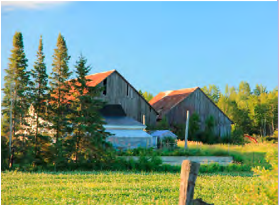
22 Adresse // Numéro civique inconnu 8 e et 9 e rang de Guigues, Laverlochère, QC Propriétaire // Boucher-Gauthier S.E.N.C. Granges à combles triangulaires
