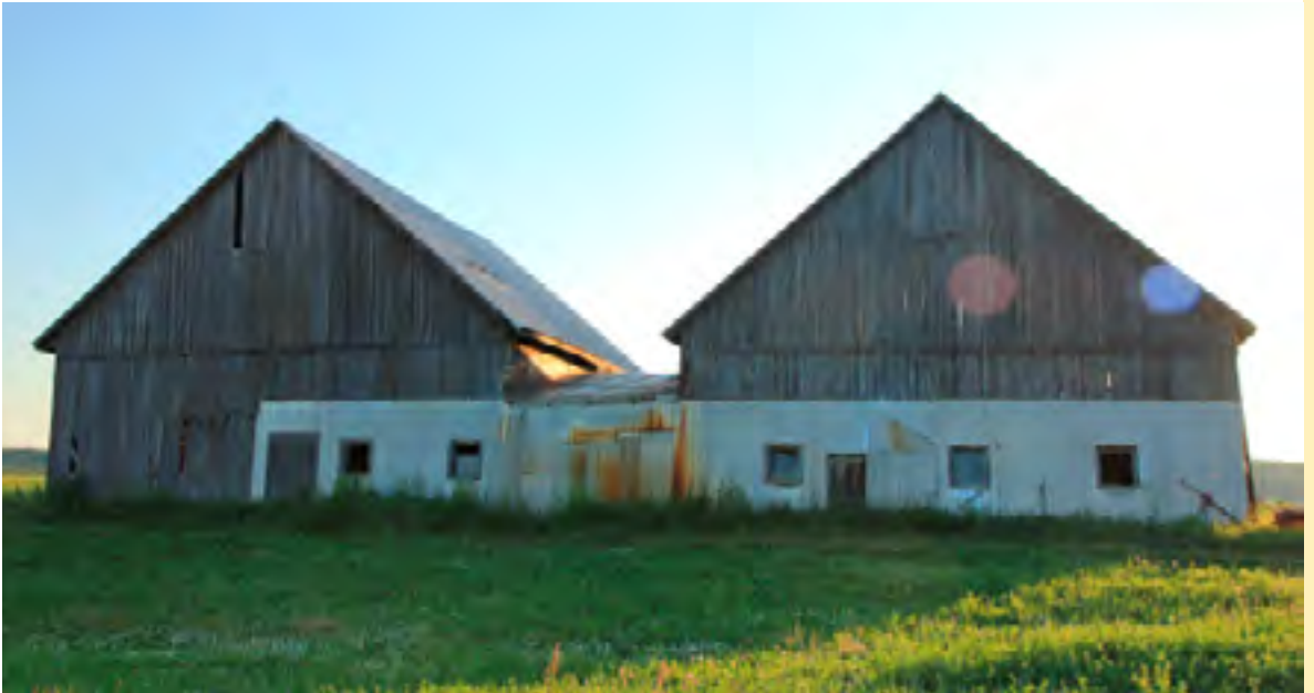
34 Adresse // 915 6 e et 7 e rang Nord, Lorrainville, QC Propriétaire // Ferme Baril Bon Lait Granges à combles triangulaires
