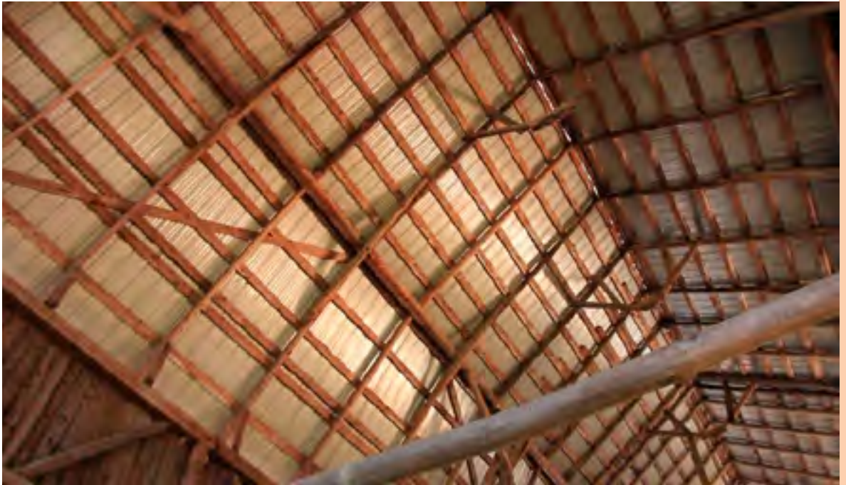
// Charpente du comble français vue de l'intérieur
