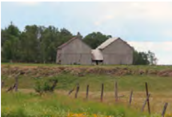
7 Adresse // Numéro civique inconnu, Route 382 Fugèreville, QC Propriétaire // Ferme l'Étoile blonde Granges à combles triangulaires
