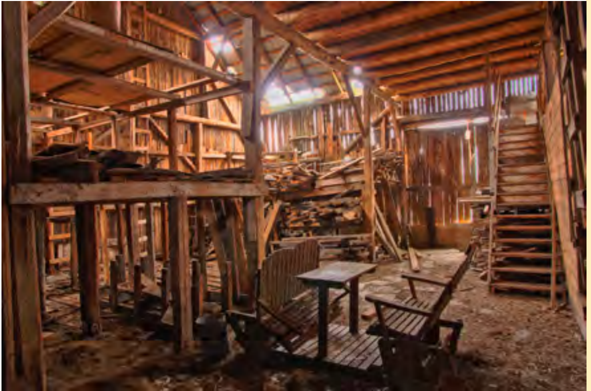
// Entreposage de bois
