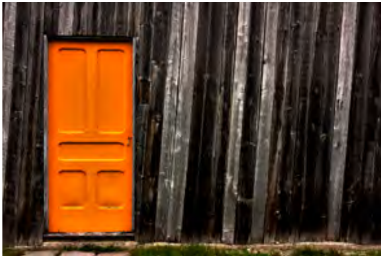
// Porte façade Ouest
