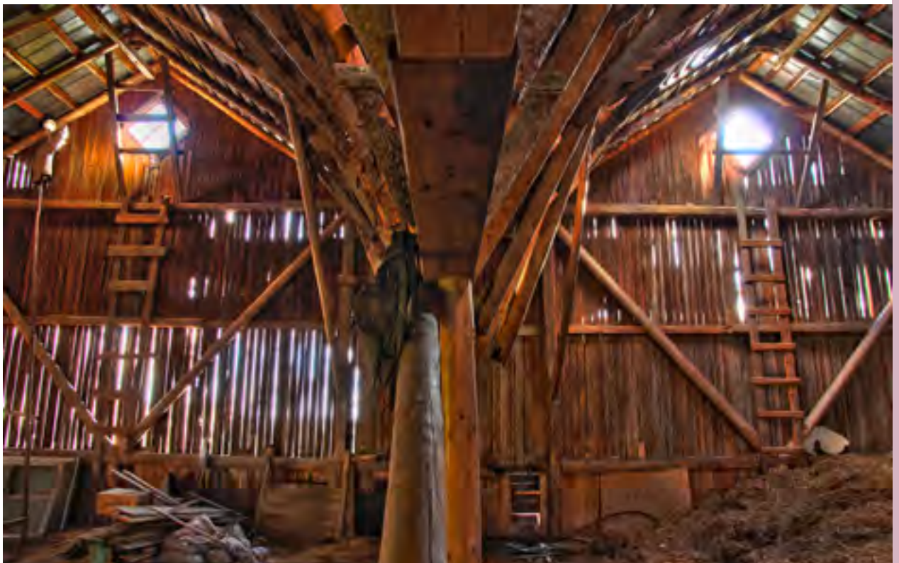
// Deuxième étage au-dessus de l'étable à lait, extrémité Sud
