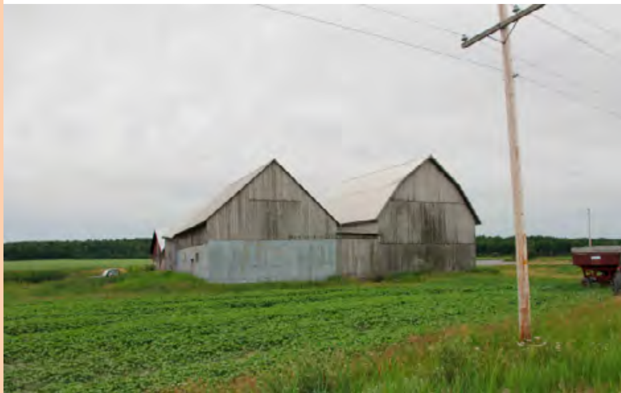
15 Adresse // 274 Route 382, Latulipe, QC Propriétaire // Ferme Lyserol Granges à combles asymétriques, triangulaire & français
