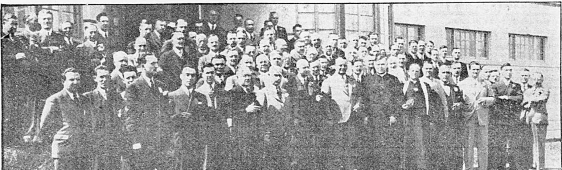
Une magnifique réception avait lieu samedi après-midi à la Beaver Products Co Ltd., pour marquer l'inauguration du nouvel établissement de cette compagnie à Ville St-Laurent. Cet édifice d'un genre du dernier modernisme sert à l'entrepôt et à la fabrication des produits "Élégant", qui sont leur spécialité, et de spacieux bureaux y sont aménagés. Ce groupe d'invités a été photographié devant l'établissement peu avant la visite et la bénédiction des lieux. On remarque entre autres, MM. Hervé Duquette, vice-président, V.-R. Boulich, gérant général, J.-B. Hamel, président, Zénon Brière, secrétaire-trésorier, Roméo Béribeau, directeur, W. Chales, ainsi que le frère de M. Brière, M. l'abbé Napoléon Brière, qui a béni l'établissement, et le R. P. A. Théorét, c.s.c., curé de Ville St-Laurent. — Voir compte rendu en 17e page. — (Photo "L'Illustration Nouvelle").
