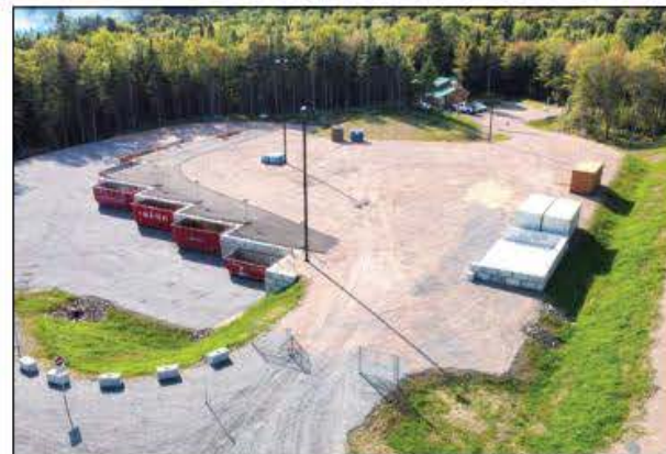
Vue aérienne de la section des conteneurs de l'écocentre de Lac-Beauport.
